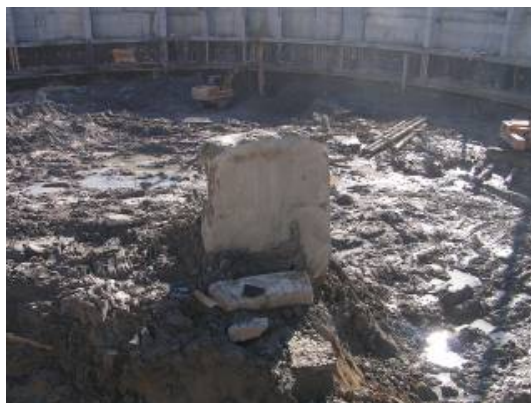
Рис. 1. Опытная захватка «стены в грунте» в процессе откопки
