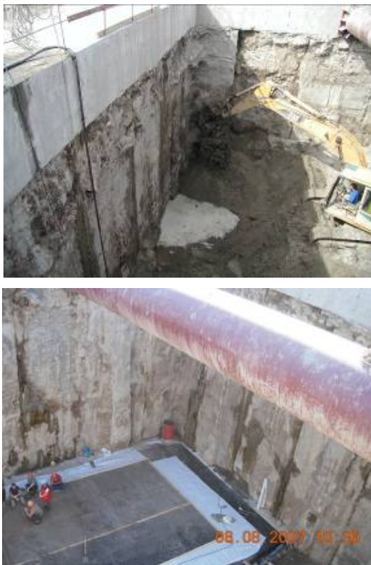
Рис. 2. Рампа Орловского тоннеля с ограждением по технологии «стена в грунте»
